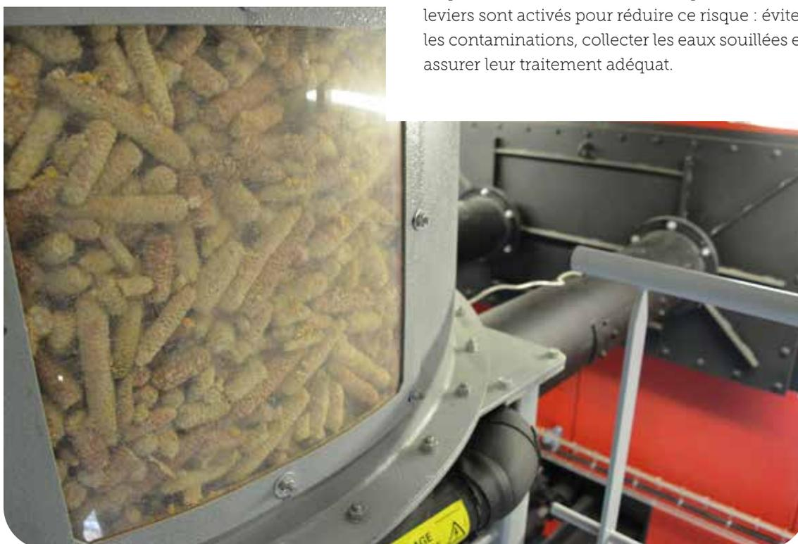
Limagrain Ingrédients : chaudière installée sur le site d'Ennezat (France) valorisant en énergie les rafles de maïs provenant de la production de semences de Limagrain Coop.
